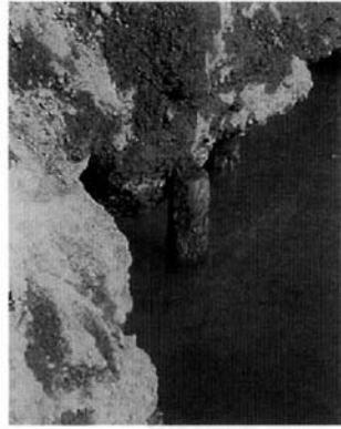
写真6 引き抜く前の基礎マツ杭の状況
