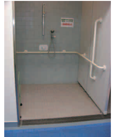
障害者・高齢者等の方でも利用しやすいシャワー室の例 (障害者交流プラザ)
